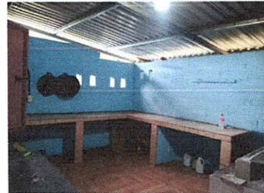
Foto 2: Sustrucción de piso de acabado liso, por piso cerámico antideslizante en área de cocina.
