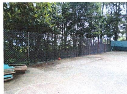
Foto 4: Sustrucción malla de acero galvanizado en perímetro del establecimiento, con instalación fija y tensa, anclajes metálicos en intervalos regulares.
