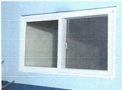
Foto 3: Sustrucción de ventanas; sistema de apertura: Corredizas, Perfiles color blanco estándar, Material del marco: PVC Material de la ventana: Vidrio, sellado perimetral
